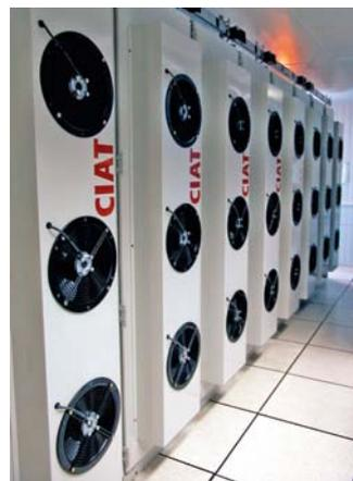
Im Rechenzentrum des LHC Teilchenbeschleunigers tragen 400 „Climrack“-Regalkühleinheiten zum einwandfreien Betrieb der PC-Farmen bei
