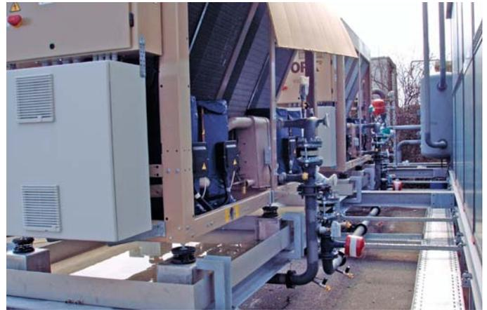
Der „Glykolprotektor“ für Flüssigkeiten der Wassergefährdungsklasse WGK1 bis WGK3 verhindert, dass Wasserglykol, das aus Kälte- und Klimaanlage austreten kann, bei Regen ausgespült wird
