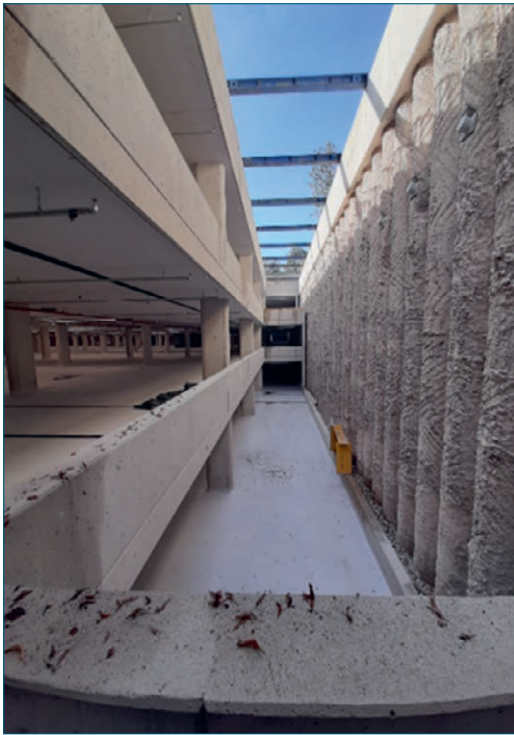
Bild 23: Beispiel der Zuluft einbringung über einen Lichtschacht in einer Großgarage Quelle: TROX X-FANS GmbH
