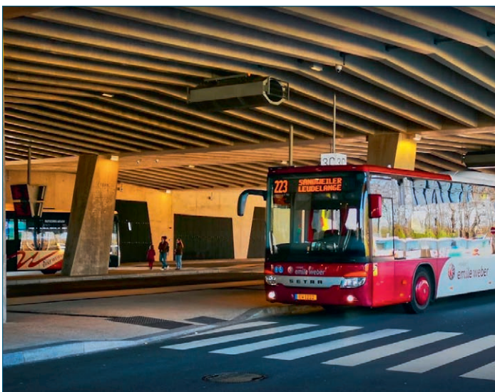
Bild 29: Überdachter Busbahnhof mit Jet-Ventilatoren zur gezielten Rauchableitung im Brandfall Quelle: TROX X-FANS GmbH
