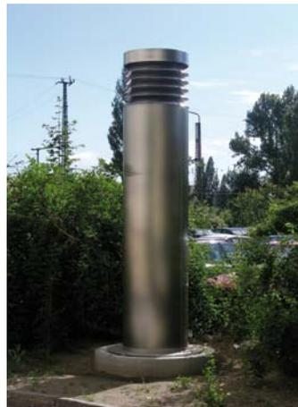
Bild 4a: Außenluftansaugung für einen Luftbrunnen
