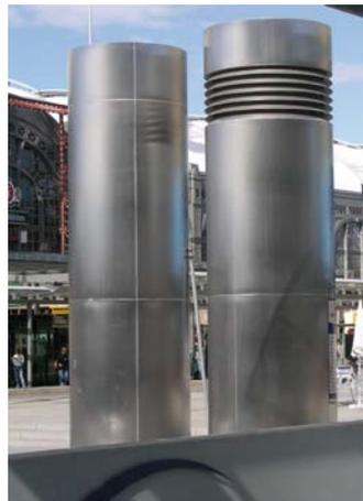
Bild 4b: Außenluftansaugung und Fortluftführung für RLT-Anlagen im Untergeschoss
