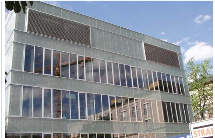
Bild 1a: Außenluftansaugung und Fortluftgitter an einem Laborgebäude
