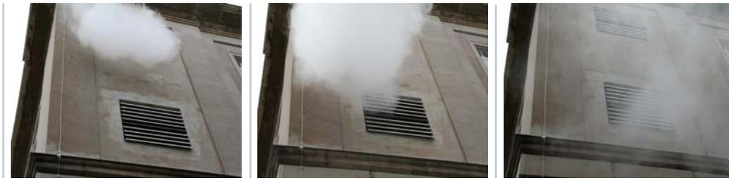
Bilder 6a bis 6c: Kurzschlussströmung zwischen der Fortluftöffnung (oben) und der Außenluftansaugung (unten)
